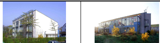
● 차양이 설치된 남동측 전경 ● 발코니가 설치된 북측 파사드 주) 1991년 Bott/Ridder/Westermeyer 교수에 의해 설계된 4세대용 공동주택으로 세대당 156㎡ 면적과 지하층에 열교환장치설치를 설치하여 에너지 소비 최소화를 시도한 실험주택임. http://www.passivhaustagung.de/
